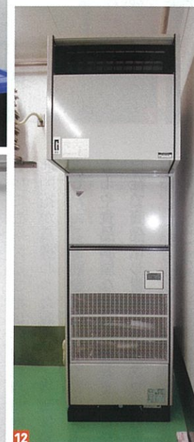
12 充填室内は陽圧で、クリーンルーム用エアコンを設置 / 13 充填機にキャップを供給する自動搬送装置 / 14 えごま油とアマニ油の系統切り替えは手動でも可能
