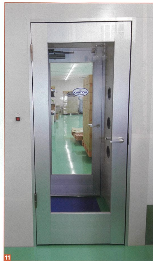
8,9 手動ラベラーと搬送機付き捺印機 / 10 充填機や印字機などの洗浄方法を記載したサニテーションマニュアル / 11 充填室と包装室の間に設けられたエアシャワー。ユニフォームに付着した異物などを清浄化された高速ジェットエアで吹き飛ばす
