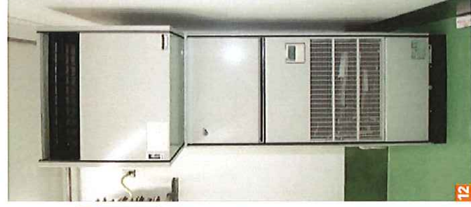
12 充填室内は陽圧で、クリーンルーム用エアコンを設置 / 13 充填機にキャップを供給する自動搬送装置 / 14 えごま油とアマニ油の系統切り替えは手動でも可能
